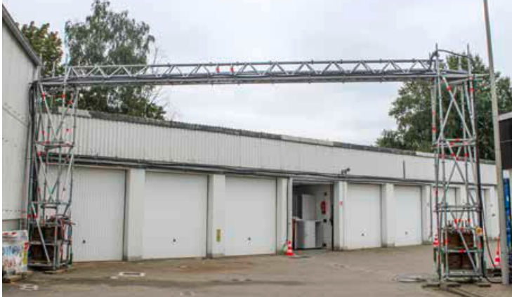
Eine Leitungsbrücke wurde auf der Zufahrt vom Hof errichtet, um den Betrieb der Stadtwerke möglichst wenig zu beeinträchtigen. Über die Brücke sind Rohrleitungen geführt, durch die die zwei Anlagenteile verbunden sind.
