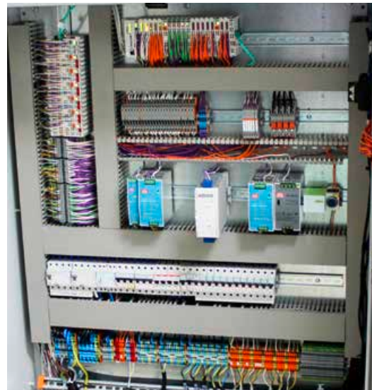
Verteilerschrank mit der elektronischen Steuerungstechnik: Es ist umfangreiche Mess- und Steuerungstechnik erforderlich, um das reibungslose Zusammenspiel zwischen den Entnahme- und Infiltrationsbrunnen zu gewährleisten.
